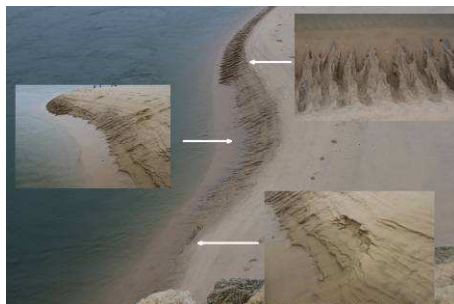
Figure 11. Photographie de différentes formes de suintement de la plage sud, en situation saturée et de forte pente. Instabilité ponctuelle sur la photographie superposée du bas.
