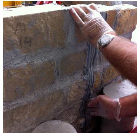
(b) Insertion d'une barre de GFRP dans une rainure sur la surface du mur
