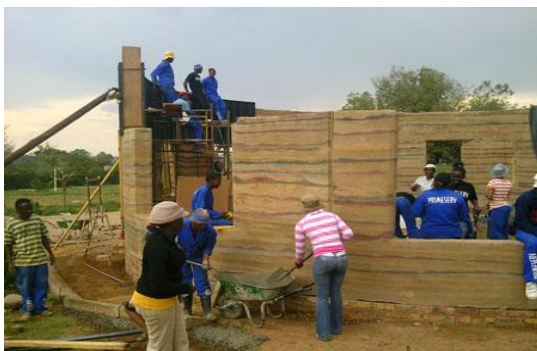
Figure 1. Une construction en pisé à l'école Mablong en Afrique du Sud ( www.specifile.co.za/ ) (a); Maison traditionnelle en pisé en Auvergne en France (b).
